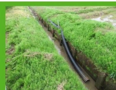
魚道（ぎょどう）の設置
