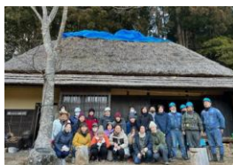
茅葺き屋根の葺き替え
