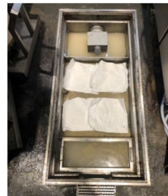
【吸着材設置状況】
