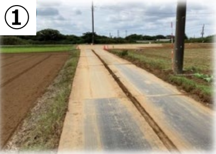
① 整地・鉄板敷設
