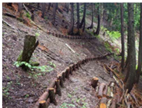
保安林整備：本数調整伐・筋工 (高島市荒谷山国有林)
