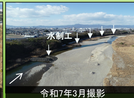
施工済水制工
