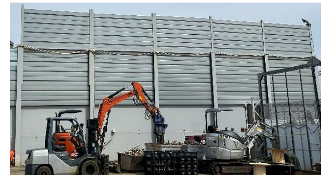
防音対策として防音壁の設置
