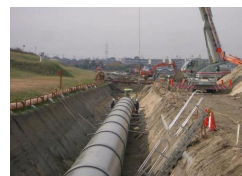
水路のパイプライン化
