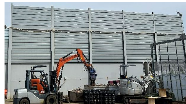
防音対策として防音壁の設置
