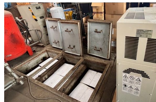
油水分離装置
