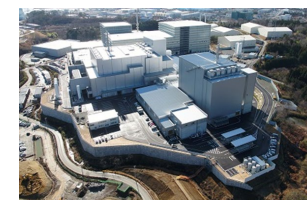
双葉町 仮設焼却施設
