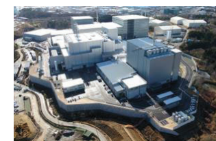
双葉町 仮設焼却施設
