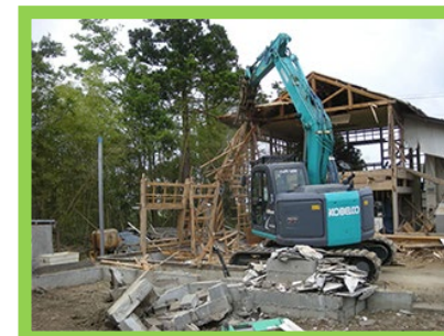
被災家屋等の解体
