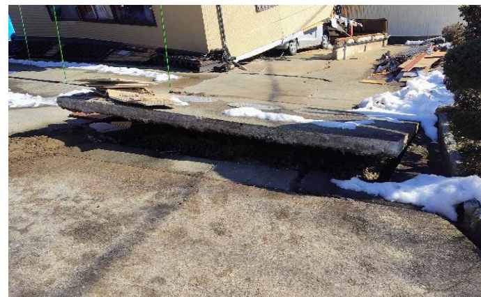
地震により浮き上がった浄化槽（画像は珠洲市内の例）
