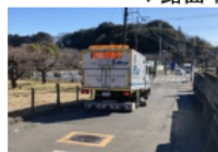
（空洞探査車による調査）
