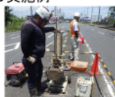
（貫入試験による調査）
