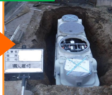
合併浄化槽設置
