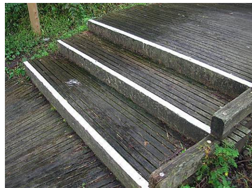
段差部を白のペイントで目立たせている 富士箱根伊豆国立公園 田貫湖集団施設地区
