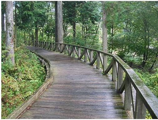
危険度に応じて、山側は立ち上がり、谷側は防護柵を設置している 富士箱根伊豆国立公園 田貫湖集団施設地区
