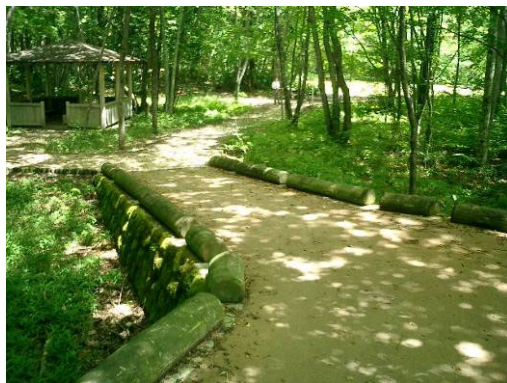
自然景観に配慮した丸太による路側処理 日光国立公園 大沼園地
