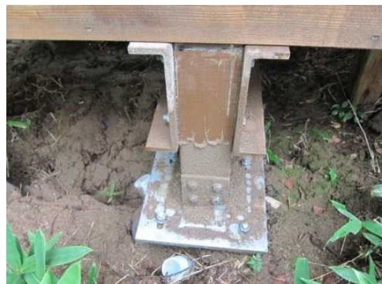
耐久性が高く、軽量で人力運搬が容易な GRP を使用した例 日光 NP (戦場ヶ原)
