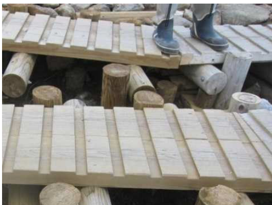
施工性を向上させるため、登山道において床板の有効厚を 60mm とした例
