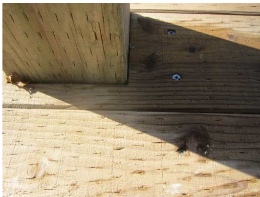
インサイジング加工の例 知床 NP
