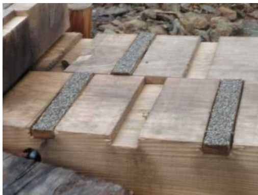
栈木に砂を付着させた特殊な滑り止めの例 中部山岳 NP
