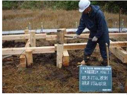
グライドを防止する木杭を設けた例（荷重を支える支柱としては機能していない）
