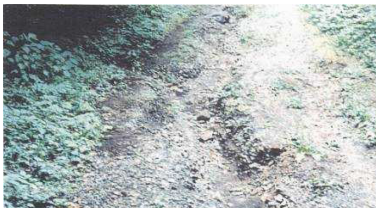
洗掘を起こしている例
