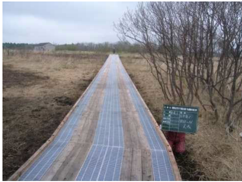
植生への採光のため床板に鋼製グレーチングを使用した例 利尻札文サロベツ NP（円山園地）
