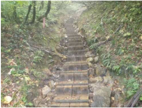
水みちとなっている歩道を覆うことにより洗掘を防止している例 中部山岳 NP
