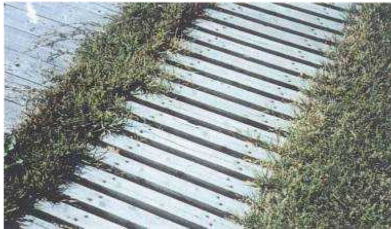
U字溝に木で蓋を掛けた例
