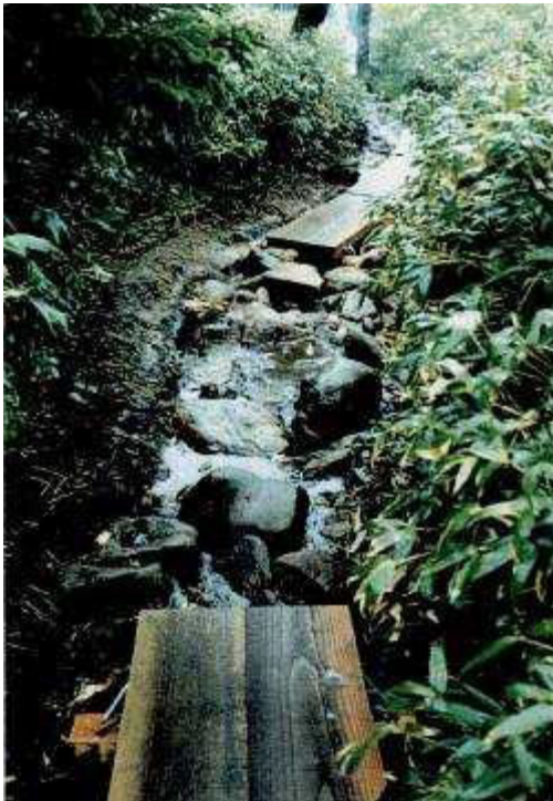
木道と現場で発生する石材で路面整正することにより、みず道になるのを防いでいる事例
