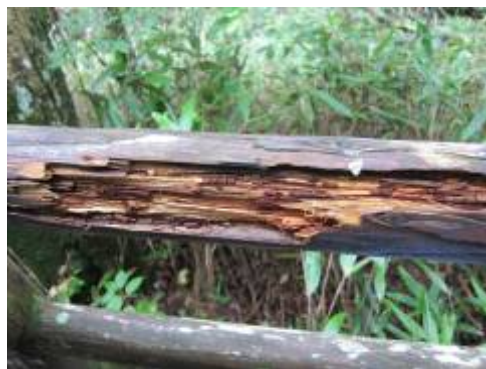
写真1 木材の腐朽
