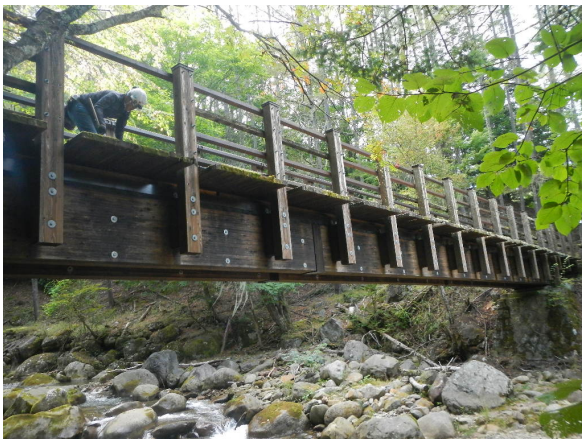
写真7 橋桁に集成材を用いた例（秩父多摩甲斐国立公園 毛木場園地 狭霧橋）
