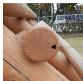
写真6 背割り加工（横架材への事例）及び横架材に芯去材を使用した事例
