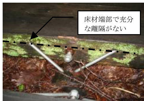
写真 20 固定ボルトや固定ボルトのかすがいの位置の問題点
