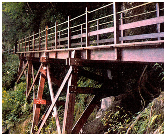
写真 23 酸性土壌に対応するため橋桁に合成木材を使用 (富士箱根伊豆国立公園 堂が島溪谷遊歩道)
