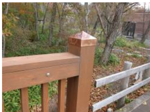
図 15 橋の高欄柱頭部分のキャップ設置（日光国立公園）
