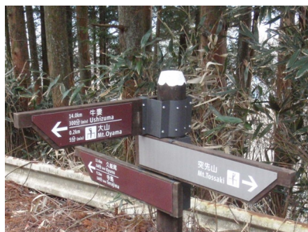
図 11 腕木を取り換えできる構造
