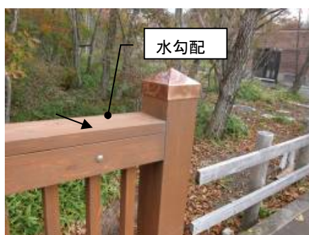
写真 17 手すり部分の水勾配の設置（日光国立公園）
