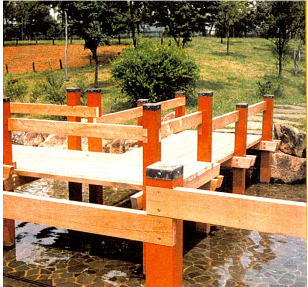
写真 24 親水池に接する支柱に腐朽しない合成木材を施工した例（亀戸中央公園）
