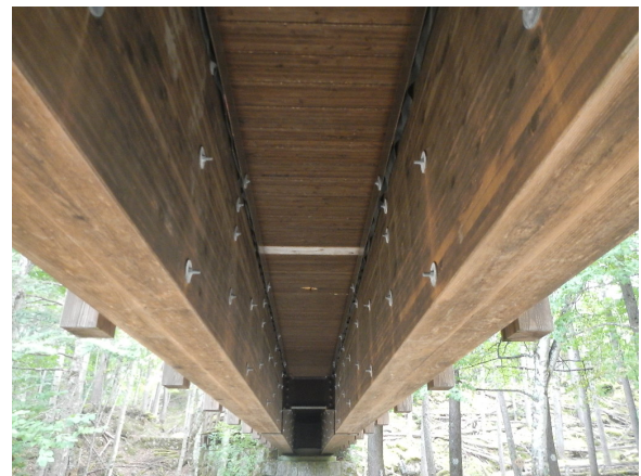
写真7 橋桁に集成材を用いた例（秩父多摩甲斐国立公園 毛木場園地 狭霧橋）
