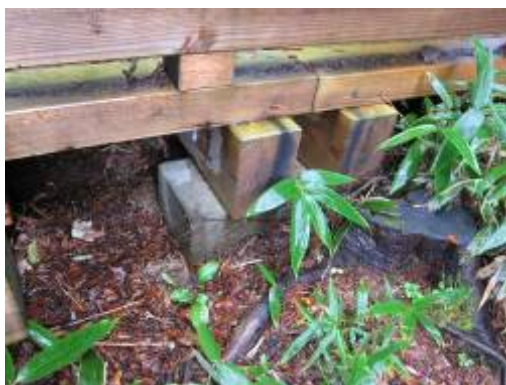
図 20 滞水しやすい部分への隙間の設置
