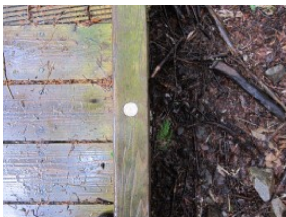
写真 13 ボルトの穴を埋めた事例・シリコンキャップ見本例
