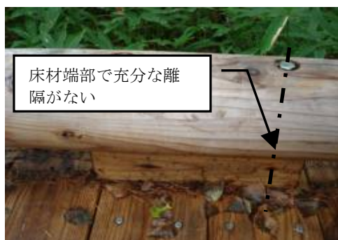
写真 20 固定ボルトや固定ボルトのかすがいの位置の問題点
