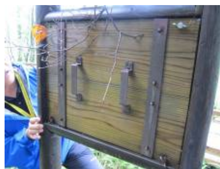
写真10 表示内容の部分を取り換えることのできる構造（日光国立公園）
