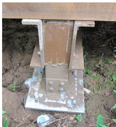
写真 23 酸性土壌に対応するため橋桁に合成木材を使用 (富士箱根伊豆国立公園 堂が島溪谷遊歩道)
