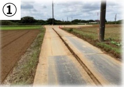
① 整地・鉄板敷設
