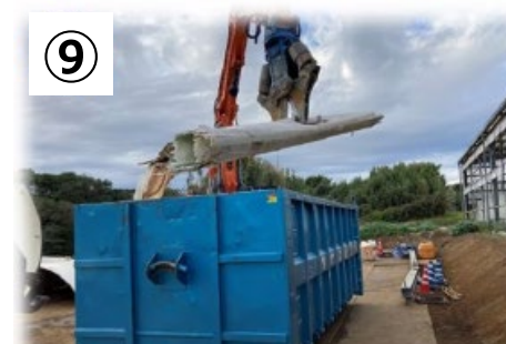
⑨ 産廃(ブレード)搬出
