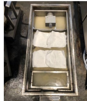
【吸着材設置状況】
