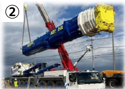
② メインクレーン組立
