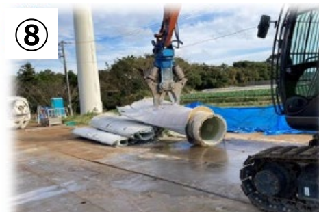
⑧ ブレード切断
