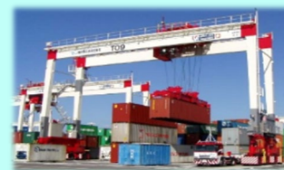
トランスファークレーン
