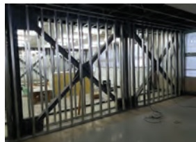
西館 2階教室内壁補強工事
