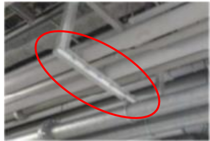
【配管の吊り金具の補強】
