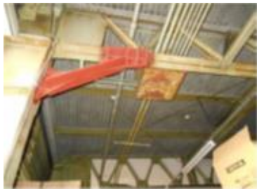
【建屋内の筋交い（ブレース）による補強】
