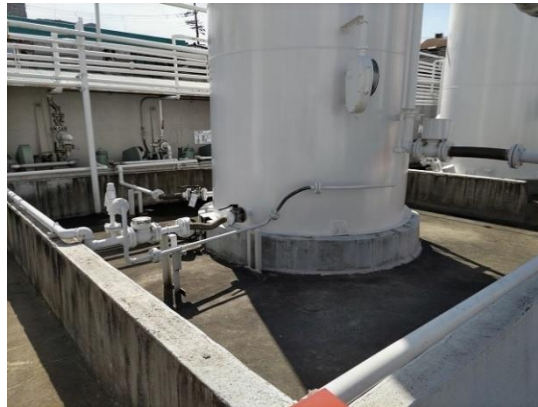
図 13 防液堤の例
