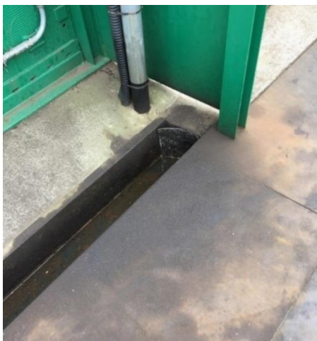
（左：ヤード周辺に排水溝を設置、右：油水分離槽の設置）
