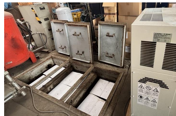
油水分離装置
