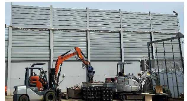
防音対策として防音壁の設置
