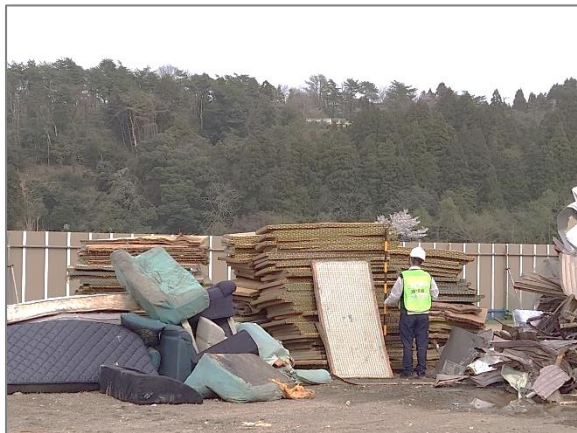
仮置場設置の技術的助言（穴水町）
