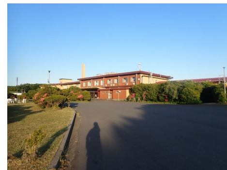
既存の宿泊施設
