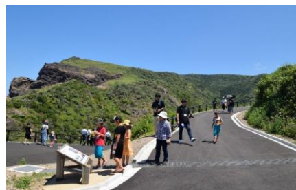
バリアフリー園路整備（隠岐西ノ島）
