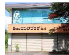
撤去予定の土産物店
