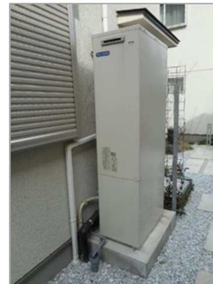
太陽熱利用ガス給湯システム
