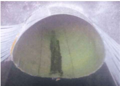
採熱施設 (下水管路内採熱管 L=65m)
