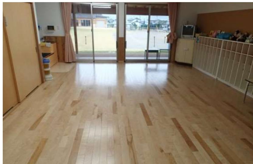
床暖房が導入された未満児保育室
