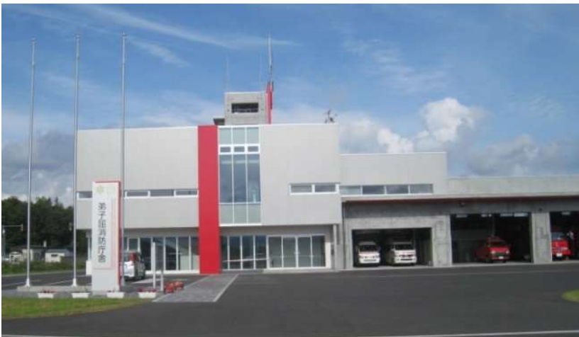
弟子屈消防署 全景
