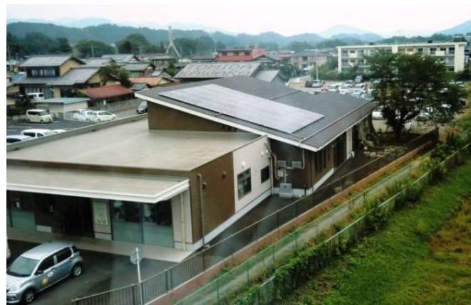
施設全景・太陽光パネル
