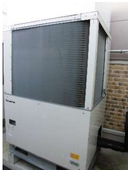
コンデシングユニット アイスクリーム、冷凍食品用のショーケースへ冷熱を供給。
