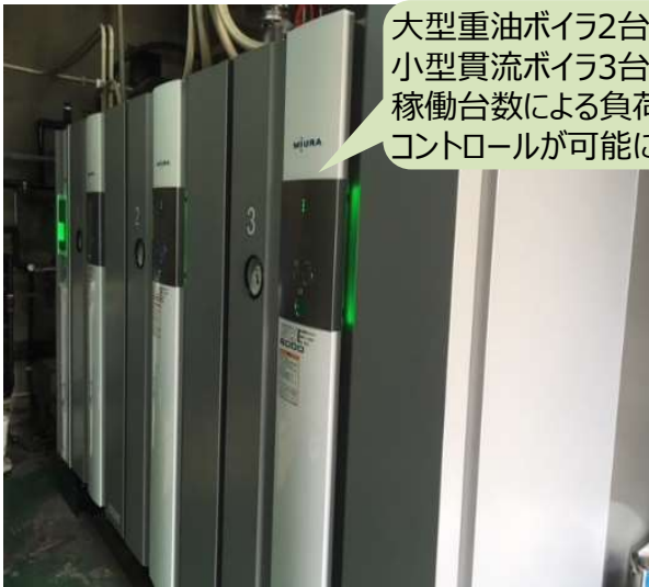
高効率ガス焚き小型貫流蒸気ボイラ
