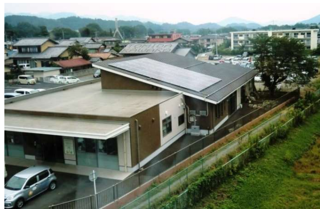
施設全景・太陽光パネル
