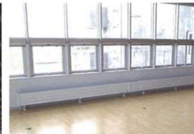
▲温水パネルヒーター【床置型】 (2階 地域防災ホール)
