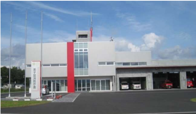
弟子屈消防署 全景
