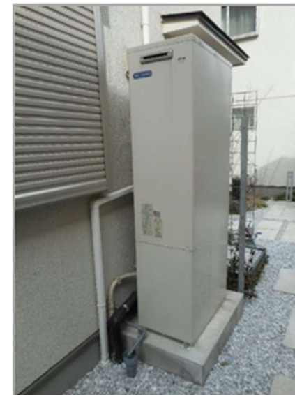
太陽熱利用ガス給湯システム
