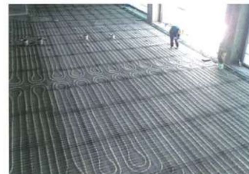
▲床暖房配管敷設 (車庫)
