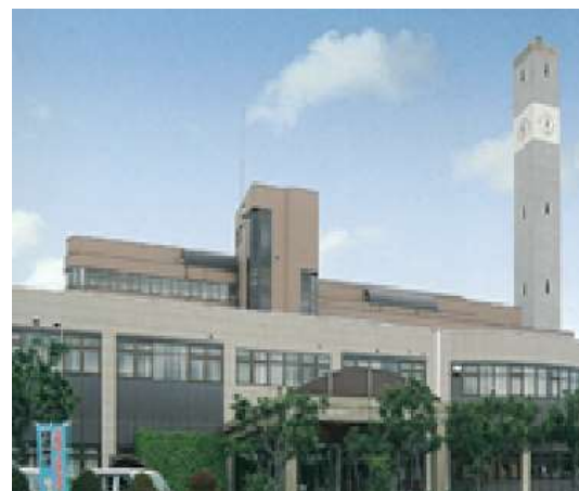
西清掃センター 外観
