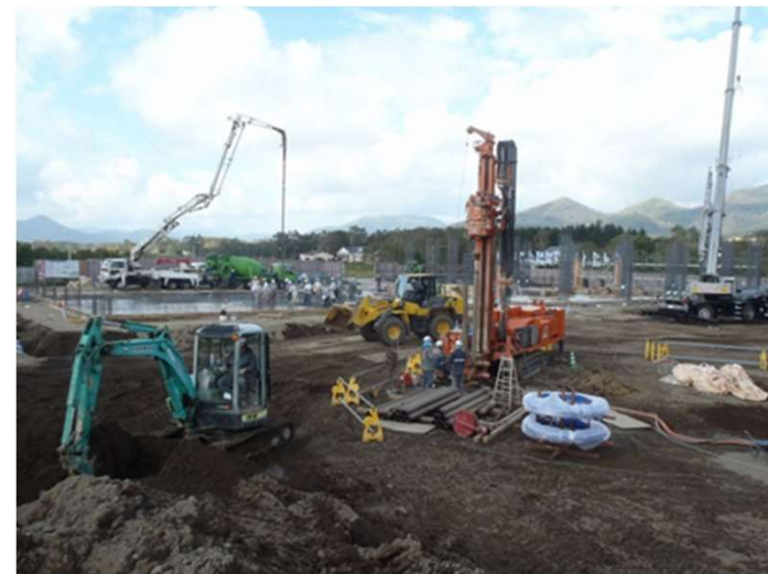
試験井掘削中
