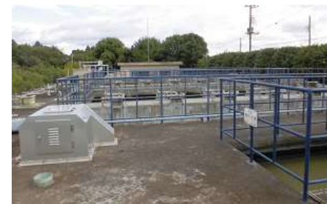
6000人槽浄化槽外観
