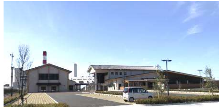
余熱利用施設
