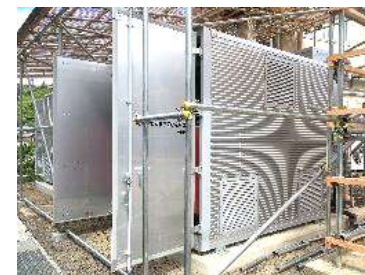
潜熱回収温水ヒーター（室外機）
