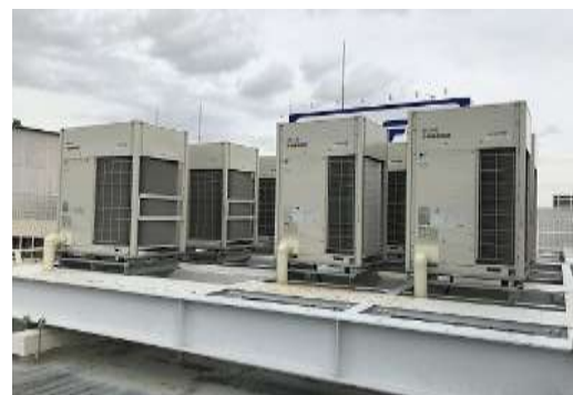
空冷ヒートポンプエアコン （室外機）
