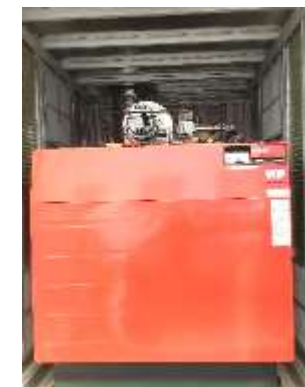
潜熱回収温水ヒーター（設備本体）
