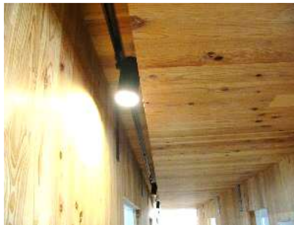
多灯分散照明方式を採用
