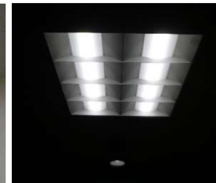
LED照明②※調光したLED照明
