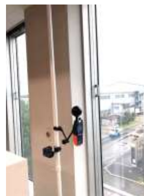
空調システム（温度センサー）
