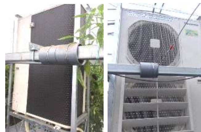
空調設備室内機
