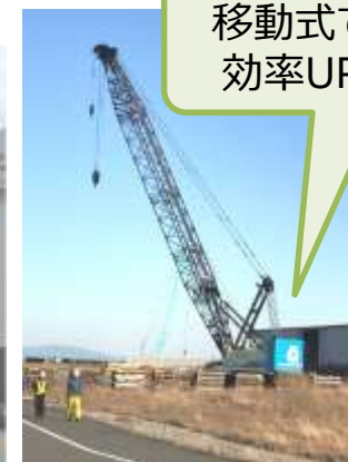
クローラークレーン
