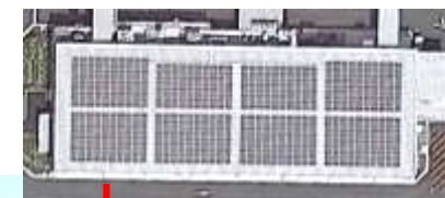
太陽光パネル（屋根上）
