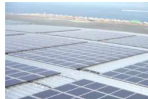
太陽光発電パネル 折板屋根への設置
