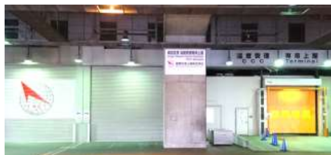
全景：成田空港の温度管理専用上屋に設置。
