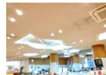
照明更新による美観向上（温泉施設）
