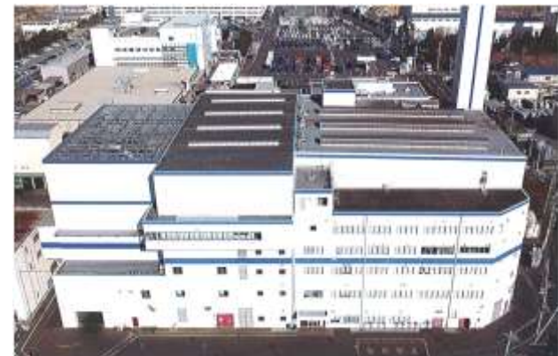
環境事業センター外観
