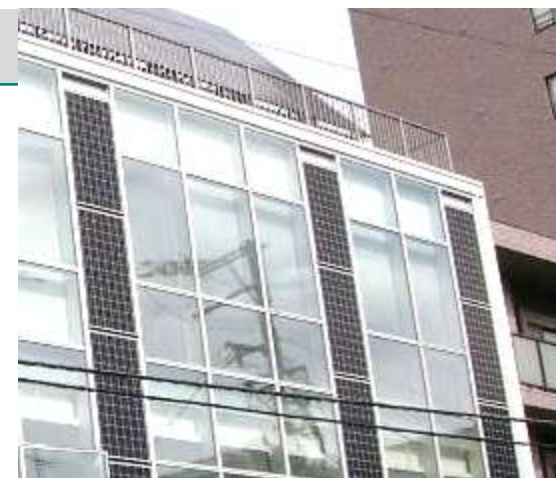
外壁にも太陽光パネルを設置
