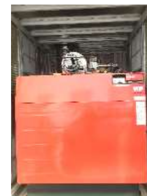
潜熱回収温水ヒーター（設備本体）
