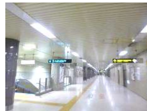
明るさを20%低減したコンコースのLED照明
