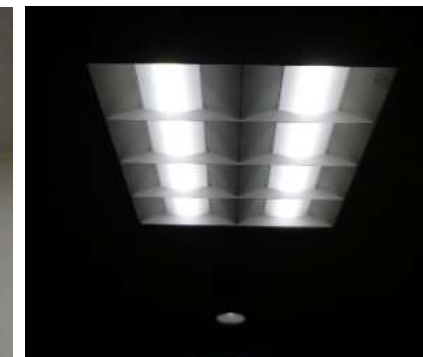
LED照明②※調光したLED照明
