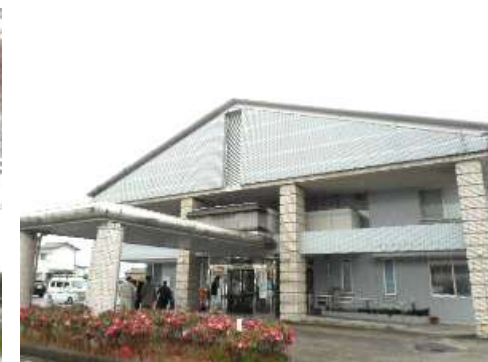
建物の外観（保健福祉センター）
