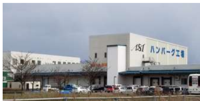
全景： ハンバーグ・メンチカツ類の製造工場に隣接する冷凍冷蔵倉庫を新設。
