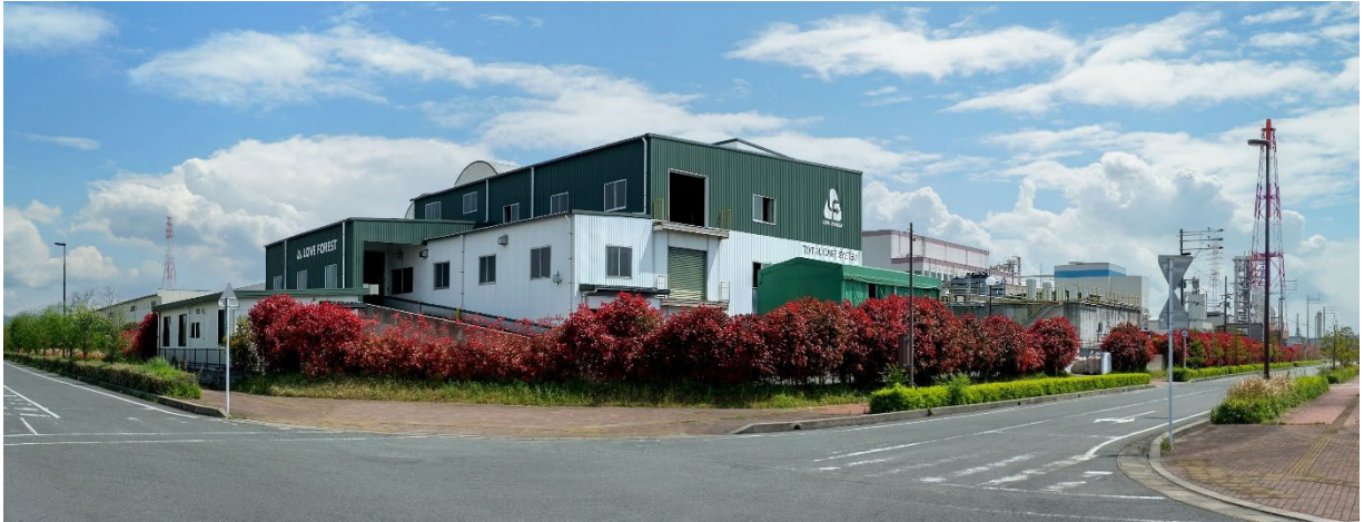
図 5-2 再生利用等施設の外観
