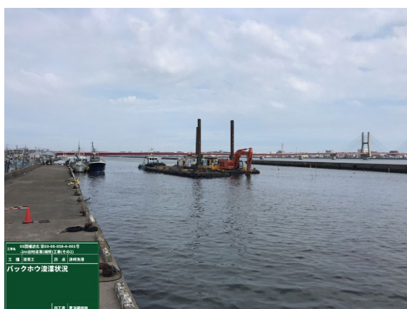
(バックホウ浚渫：水深が浅い場合)
