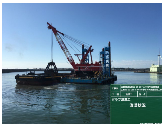
(グラブ浚渫：水深が深い場合)
