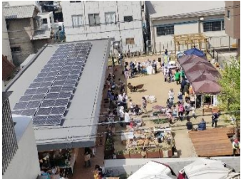
太陽光発電設備
