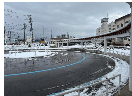
地中熱利用融雪設備が稼働している駐車場兼送迎バス乗り場
