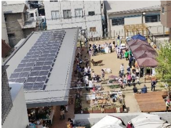
太陽光発電設備
