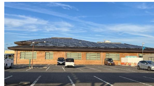
太陽光発電設備
