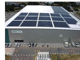
太陽光発電設備
