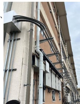
自営線 (DC1500V幹線、 DC380V幹線)
