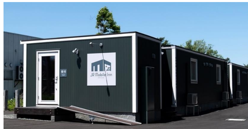
コンテナハウス 全体
