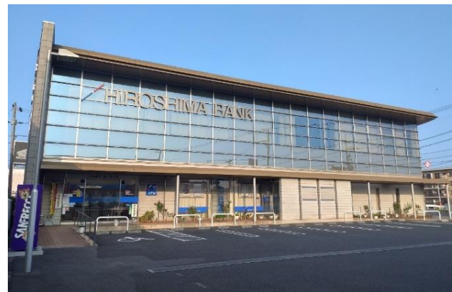
建物外観（広島銀行福山北支店）
