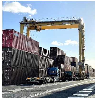
ハイブリット型トランスファークレーン
