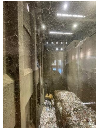
ごみクレーン
