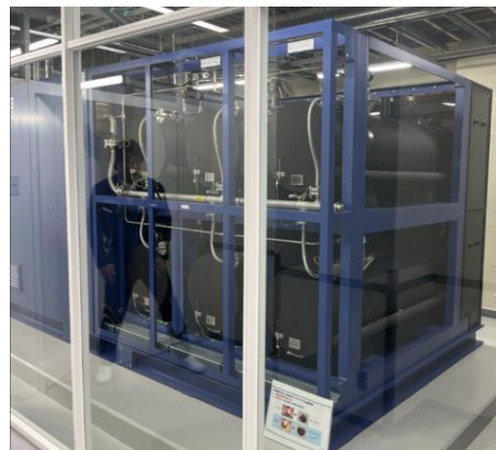
水素貯蔵装置（水素タンク部分）
